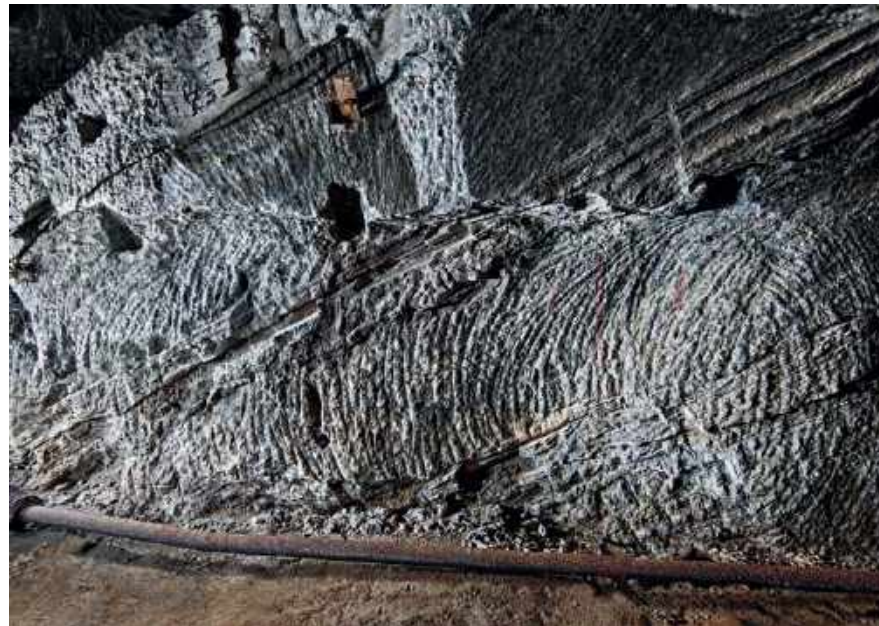
II./Fig. 7. Poziom III im. Juliusza Słowackiego. Skrzyżowanie poprzeczni Franciszek Müller z podłużnią Franciszek Müller. Odstonięcie soli zielonych pokładowych i soli szybkowej / Juliusz Słowacki Level III. The junction of the Franciszek Müller Crosscut and the Franciszek Müller Ramp. Visible green deposit salts and shaft salts. Fot./Photo by A. Nowakowski
